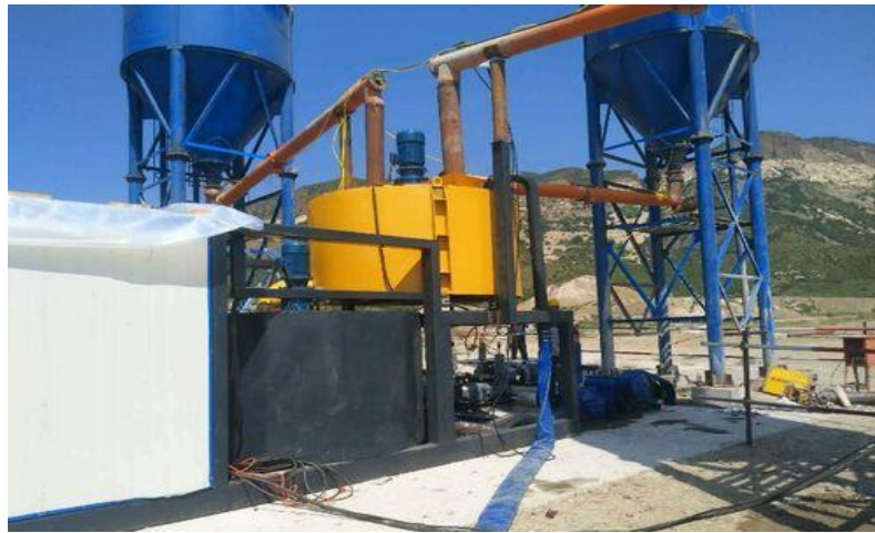
图 9 固化稳定化施工
